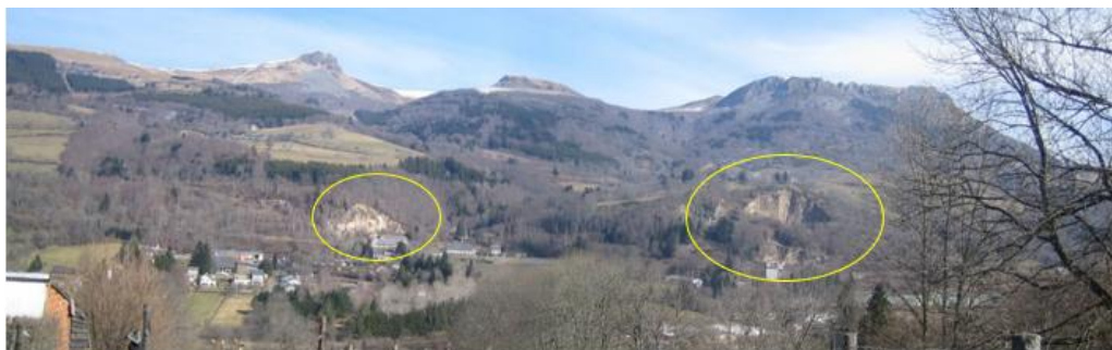
Des carrières locales situées en limite de commune, sont visibles dans le paysage.
