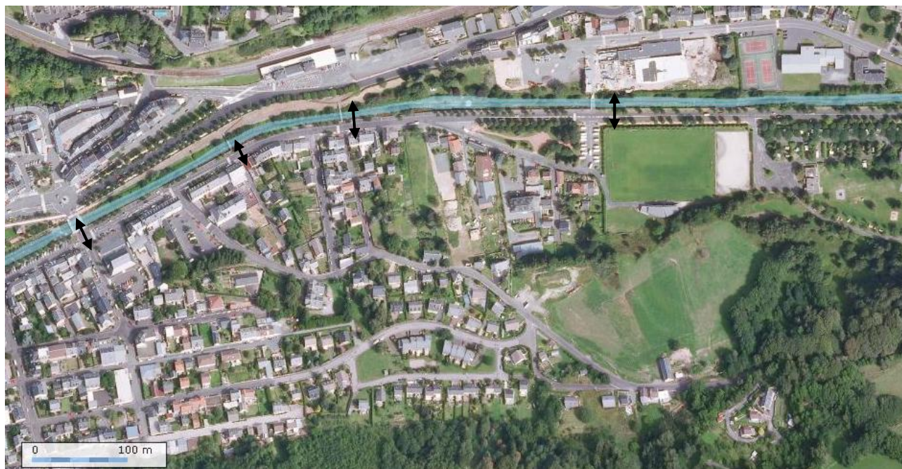
Partie Est de la station. L'ensemble de ces passages facilitent les déplacements motorisés et surtout piétonniers.
